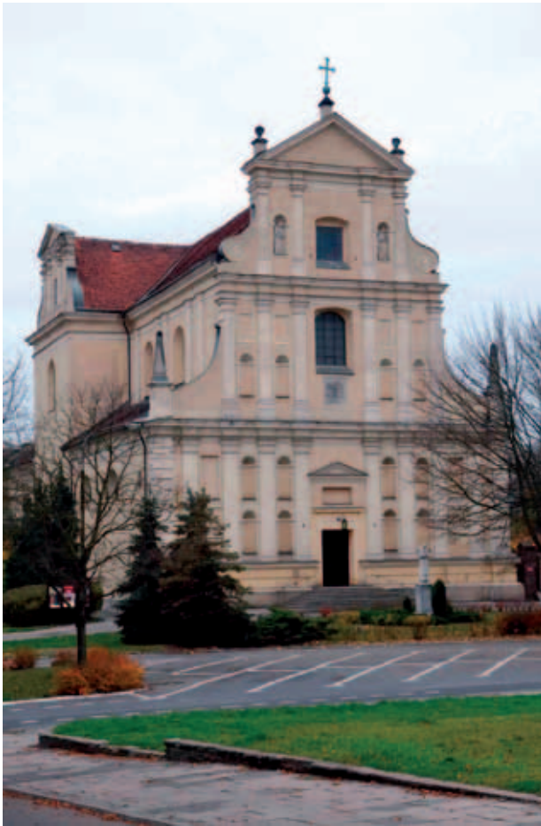
5. Kościół pw. św. Józefa w Poznaniu – widok fasady po odnowieniu, stan w 2008 r., fot. K. Pawłowski OCD
