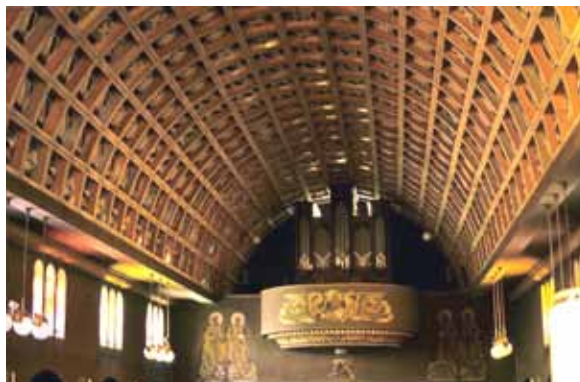
14. Strop, kościół parafialny w Orsonnens, 1934–1936, arch. Fernand Dumas, fot. J. Wolańska
