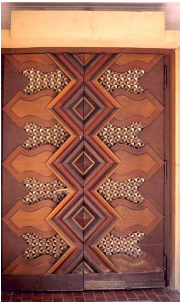
13. Drzwi w portalu głównym, kościół katolicki w Travers, 1937–1939, renowacja Fernand Dumas, fot. J. Wolańska
